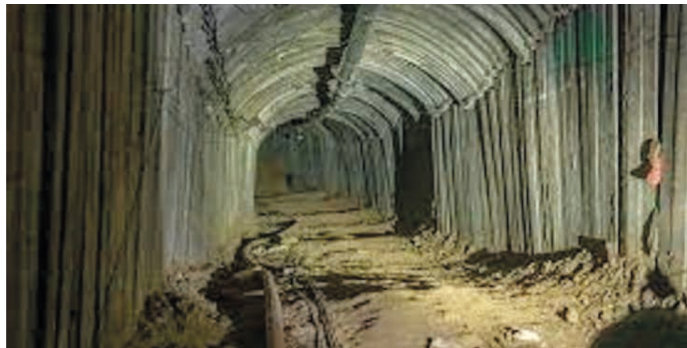
Rafahiin Siinaille johtava tunneli.
